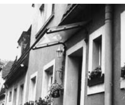
der jeweiligen Eingangssituation und ist mit der Unteren Denkmalbehörde abzustimmen. Die Befestigung hat mit verzinkten Stahlwinkel zu erfolgen. Zwischen der Glas- bzw. Plexiglasplatte und der Gebäudeaußenwand ist ein Abstand von 2 cm einzuhalten.
