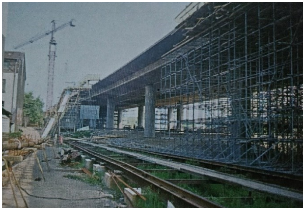
Abbildung 3: „Brücke Meiderich“ Blick von der Herbststraße in Richtung Norden.
