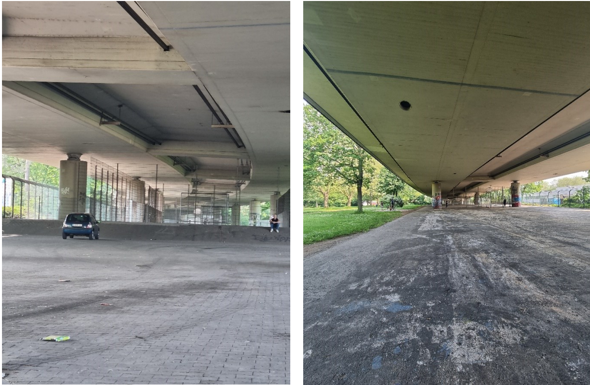
Abbildung 16: Bestandssituation im Bereich Brückenbauwerk Gartsträuch
