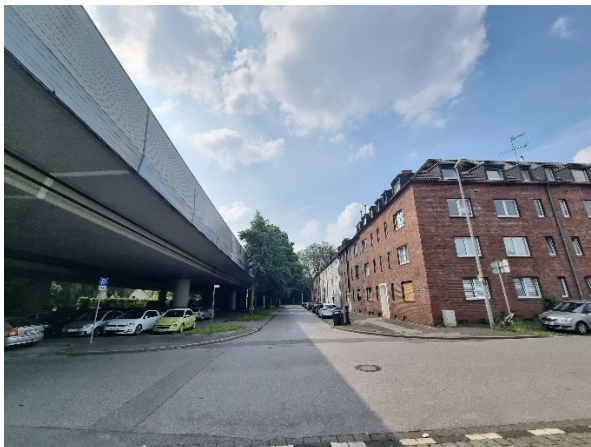
Abbildung 23: Bestandsituation Dr.-Lengeling-Straße Mittelmeiderich.
