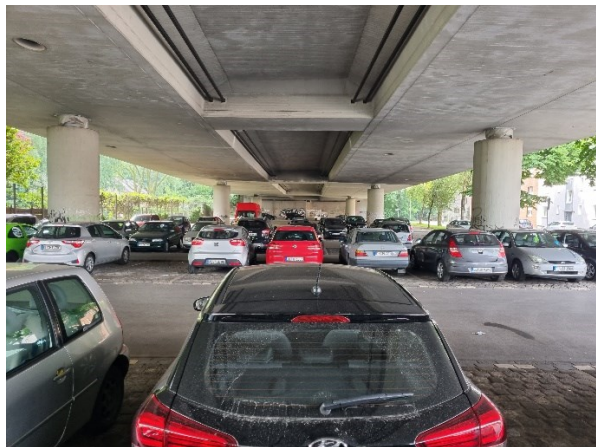
Abbildung 17: Bestandsituation Brückenzug Mittelmeiderich
