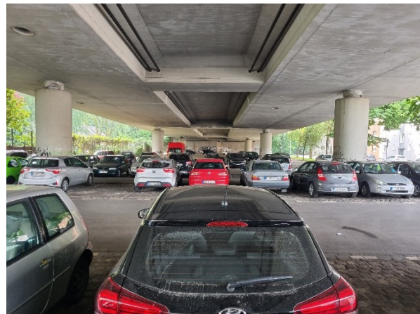
Abbildung 24: Bestandsituation Brückenzug Mittelmeiderich.
