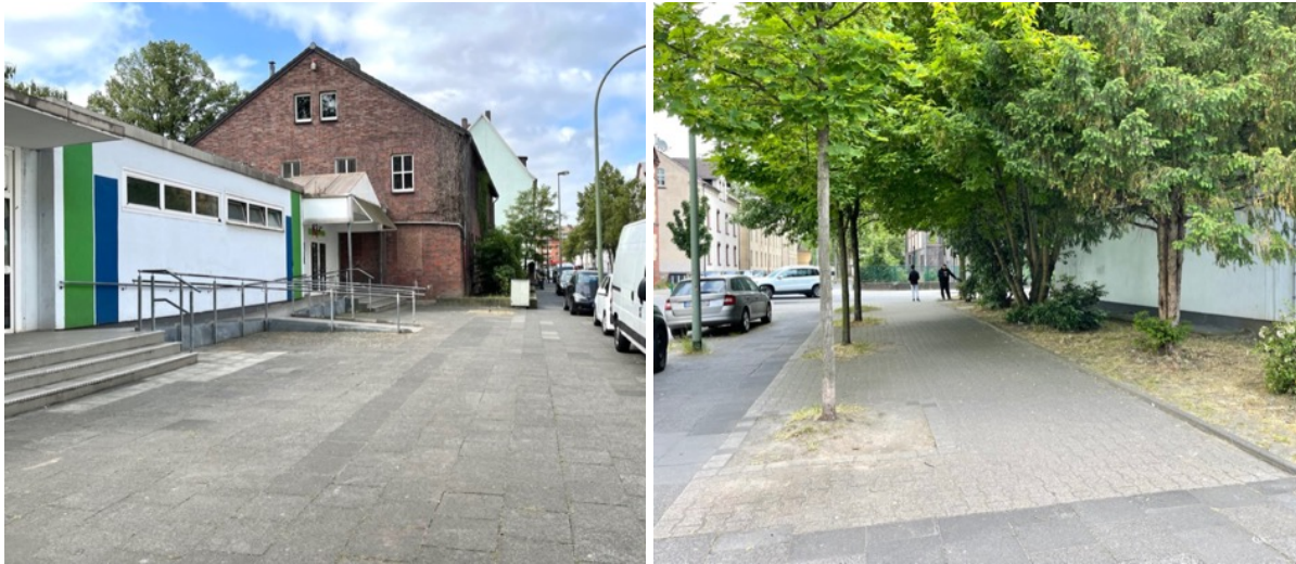
Abbildung 20: Unstrukturierter Übergang vom öffentlichen Raum in die halböffentlichen Bereiche der Jugendeinrichtungen in der Marienstraße
