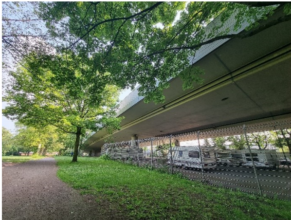
Abbildung 10: bestehender Wohnmobilstellplatz im Bereich Brückenbauwerk Gartsträuch
