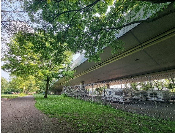
Abbildung 17: Bestehender Wohnmobilstellplatz im Bereich Brückenbauwerk Gartsträuch
