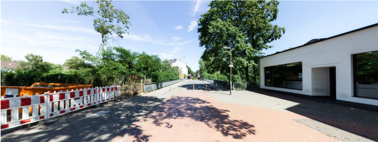
Abbildung 8: Bestandssituation im Bereich Jägerstraße.
