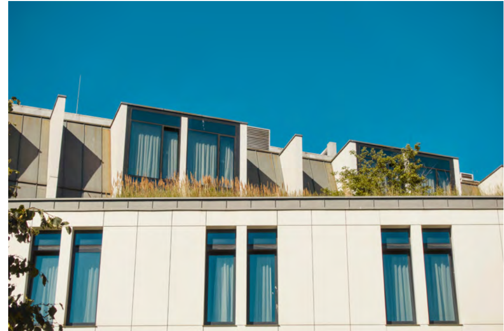
Begrünte Dächer wirken temperaturnausgleichend und entlasten die Kanalisation.
