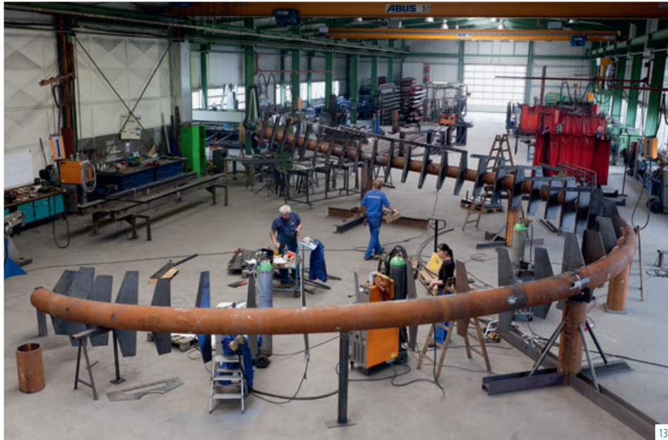
Abb. 13-15) Vormontage bei der Firma Gründken in Nottuln, Probeaufbau der Looping- und Tragrohrsegmente zur Anpassung der Treppen- und Geländergeometrie, Schleifen der Schweißnähte an den Querträgern, Mai-September 2011
