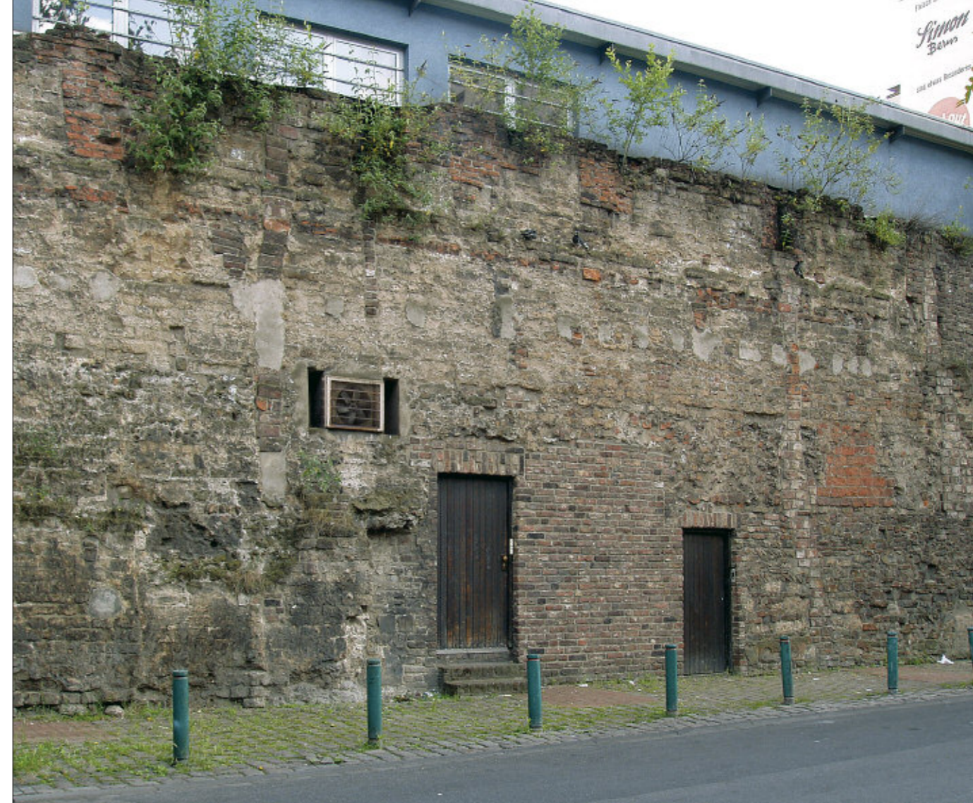
Erhaltene Stadtmauerreste an der Untermauerstraße mit dem ältesten Bestand aus dem späten 10. bis frühen 11. Jahrhundert sowie der Tuffmauer aus dem 12. Jahrhundert
