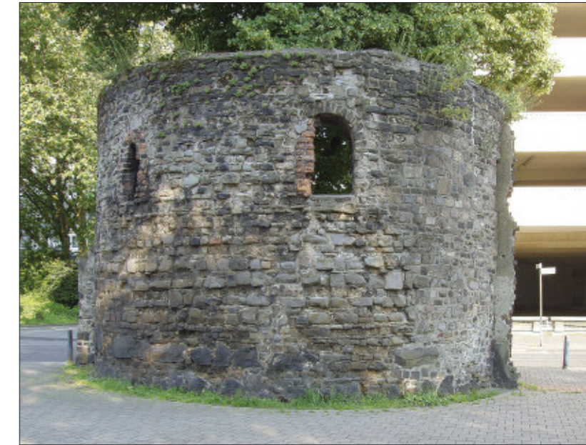
Hochmittelalterlicher Wohnturm wohl des 12. Jahrhunderts, der im 14. Jahrhundert nachträglich in die Stadtbefestigung einbezogen wurde
