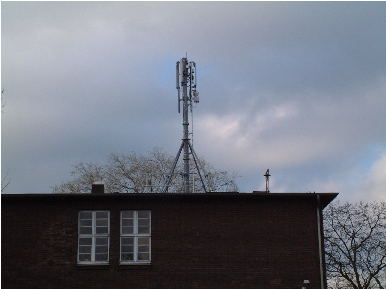
Bild 4.5 Flachdach mit aufgesetzter 3 Sektor Mobilfunkanlage des Netzbetreibers E-Plus Mobilfunk GmbH & Co. KG
