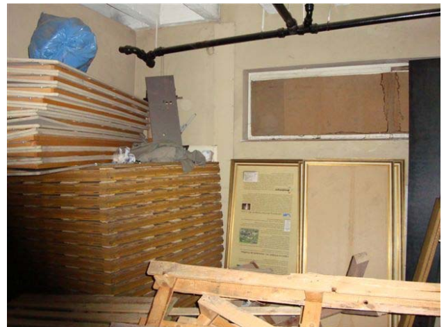
Abbildung 19: Ein Raum wird noch als Lager genutzt.
