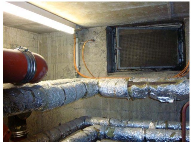
Abbildung 10: Im Keller sind Fenster vorhanden.
