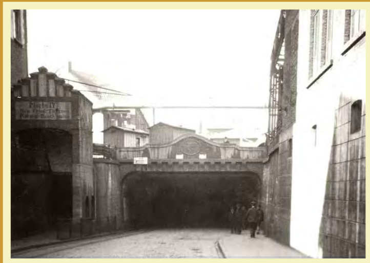
Die "Straße unter der Eisenhütte". Der neue Matenatunnel 1911. Mit 450 Metern Länge erste "U-Bahn" der Stadt Hamborn. (S)
