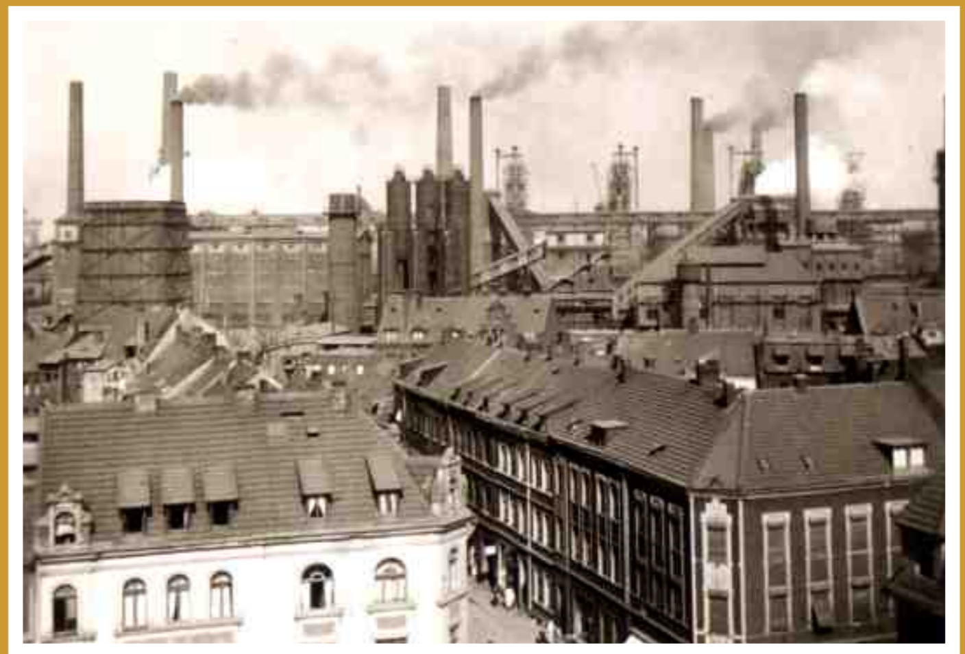
1942 - Aufnahme vom Bunker in Richtung Kronprinzenstraße, Dieselstraße und ATH (1926-46 Vereinigte Stahlwerke AG).(S)
