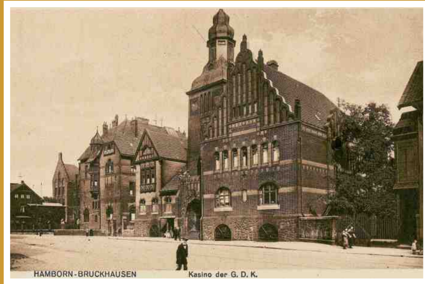
Das imposante Beamtenkasino vor der Franz-Lenze-Str., erbaut 1906. Nach 1945 provisorischer Theatersaal und Kino ATRIUM.
